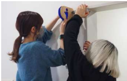
(図 10) 地震でも落ちないよう、4点留めの ピンを使用して壁に強固に取り付ける。
