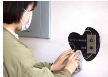
(図 18) 電気表示の取り付け
