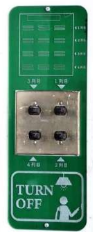
(図 16) 完成した電気表示 (1号館アトリエ)
